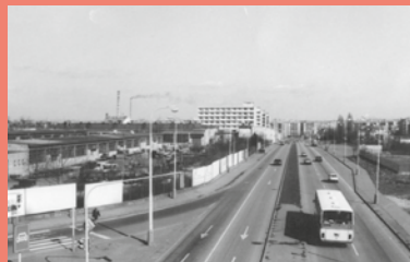
□ DŘÍVE stavební dvory, ploty, rozbořené haly
